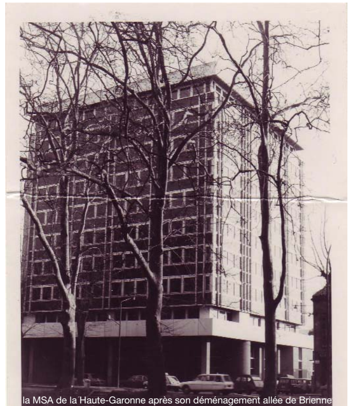
la MSA de la Haute-Garonne après son déménagement allée de Brienne
